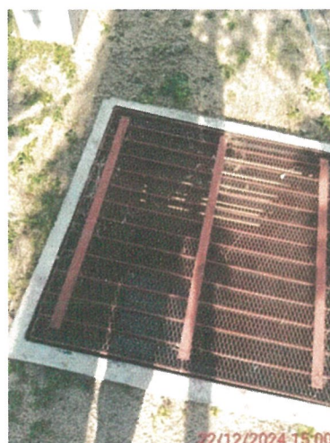
รูปภาพที่ 2.49 ตะแกรงครอบรูท่อระบายน้ำ
